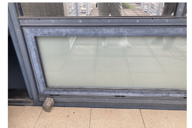
vue de l'ouvrant de désenfumage depuis l'extérieur
